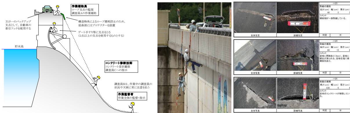
ダム堤体変状調査の概要
